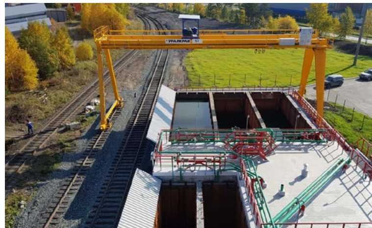
Рисунок 10. АО «ПНТЗ». «Грязный» оборотный цикл группы трубопрокатных цехов. Аппарат «ОКУД» с козловым грейферным краном. Ближние к железнодорожным путям секции оборудованы наклонными щитами для исключения загрязнения территории при выгрузке осадка в вагоны.
