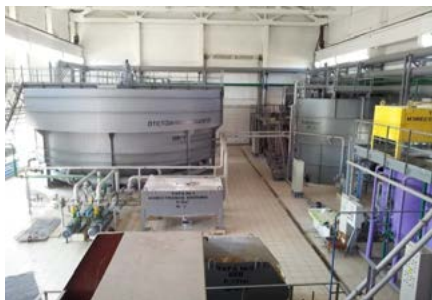
Рисунок 14. Участок физико-химической обработки сооружения очистки кислых сточных вод предприятия цветной металлургии. Отстойник-флокулятор «ЭП ОФ».
