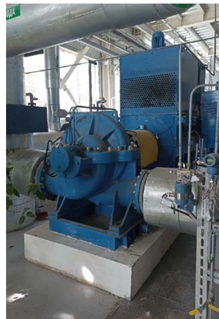
Рисунок 1. Насосы двухстороннего всасывания CNP серии NSC на Ижевской ТЭЦ-1.
