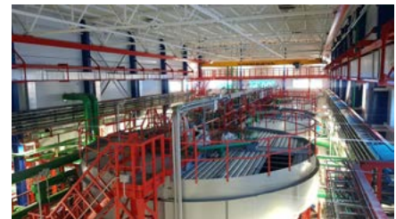
Рисунок 8. АО «ПНТЗ». Установка водоподготовки (БОС-2) системы оборотного водоснабжения НТПА цеха № 8. Участок осветления воды с тремя отстойниками-флокуляторами (технологический диаметр аппарата — 8 м., производительность - 600 м 3 /ч).
