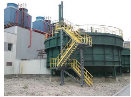
Рисунок 7. ПАО «Новолипецкий меткомбинат». «Грязный» оборотный цикл производительностью 1800 м 3 /ч. Два отстойника-флокулятора с технологическим диаметром 12 м.
