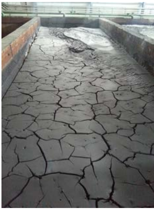
Рисунок 5. Оборотный цикл МНЛЗ. Аппарат «ОКУД» с совместно обезвоженными осадками: окалиномаслосодержащими и от установки умягчения подпиточной воды
