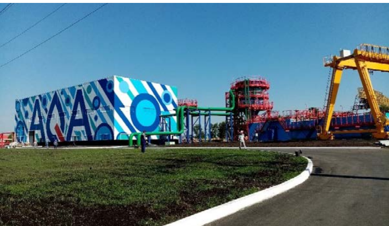
Рисунок 9. АО «ПНТЗ». Блок очистных сооружений БОС-2 «грязного» оборотного цикла ТПЦ № 8. Здание БОС-2.
