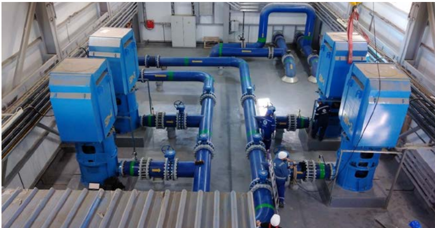
Рисунок 2. Полупогружные насосы CNP серии VTC на объекте Росатом ППГХО.
