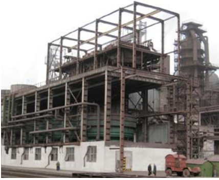
Рисунок 1. ПАО «Енакиевский металлургический завод». Блок очистки воды оборотного цикла водоснабжения газоочисток доменных печей № 4 и № 5.
